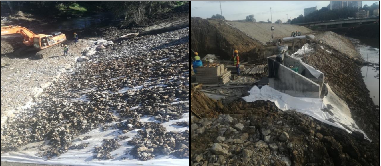
Figure 11. Pose des enrochements sur le géotextile.
