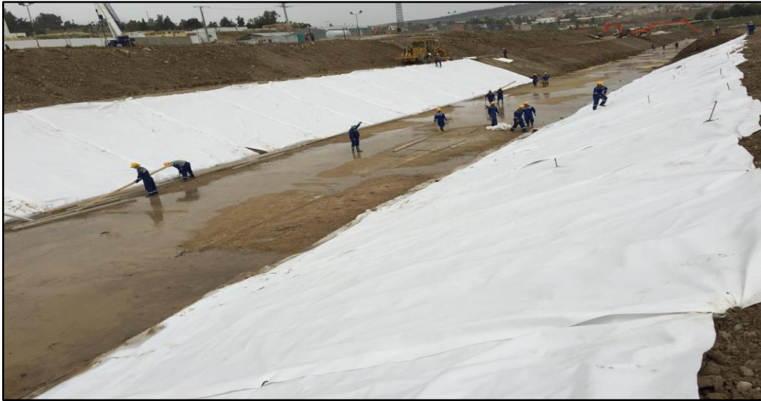
Figure 10. Pose du géotextile sur les talus des oueds.
